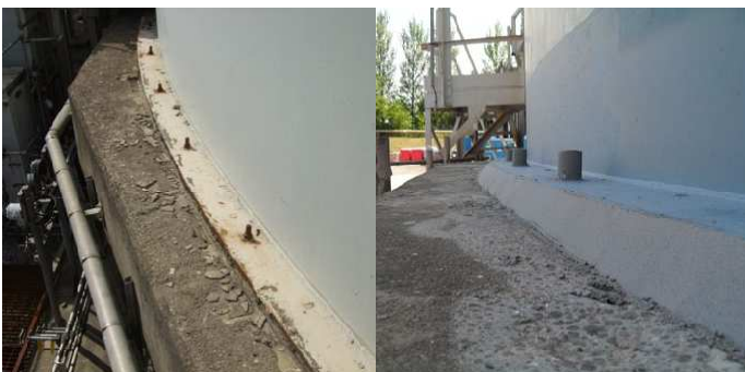
Nainštalovaný lem dna nádrže
