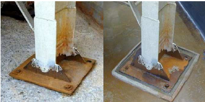
Upevnenie podpery nádrže v priestore na zadržanie chemikálií
