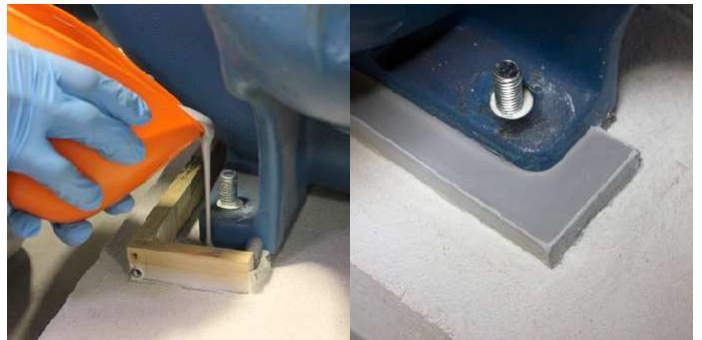
Inštalácia základu čerpadla
