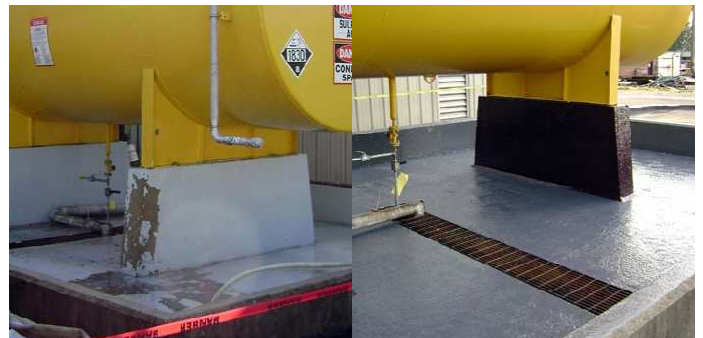
Priestor na zadržanie chemikálií natretý kvôli chemickej ochrane
