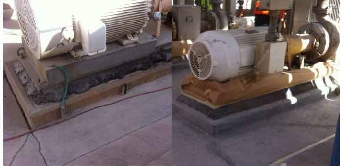
Obnovený základ čerpadla elektrolytu
