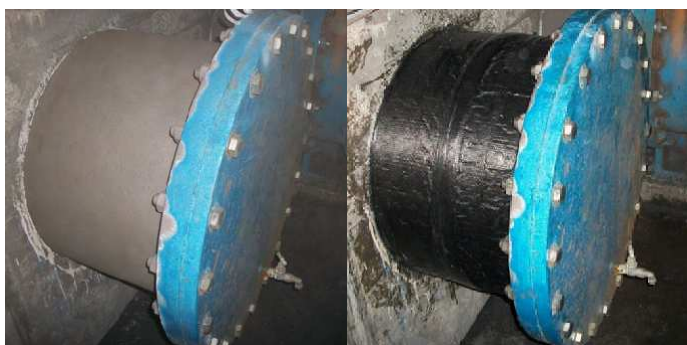
Oprava potrubia obalením
