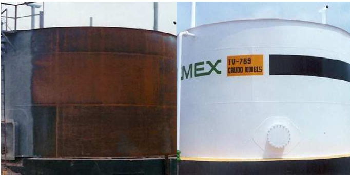
Vonkajšia ochrana nádrže
