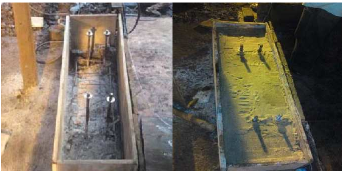
Opravený základ sita
