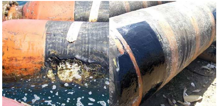
Opravená poškodená plávajúca hadica
