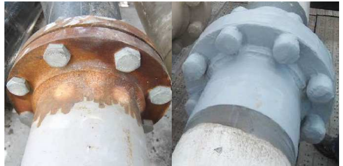
Príruba zapuzdrená na ochranu pred koróziou
