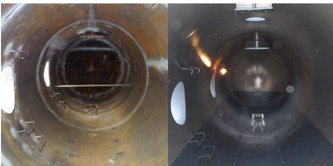
Nádoba potiahnutá na ochranu proti korózii pri zvýšených teplotách
