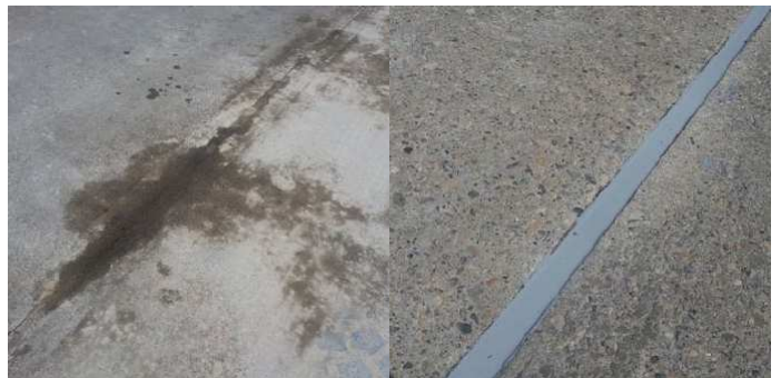
Opravený dilatačný spoj
