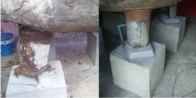
Podpery nádoby opravené vyrovnaním podložky
