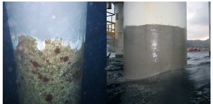
Ochránená podpera ťažobnej plošiny na mori
