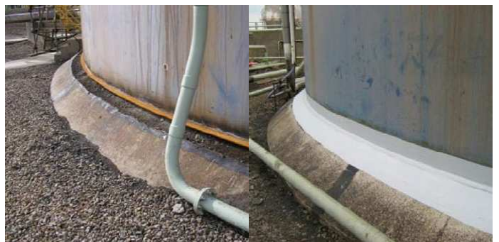
Utesnenie základu nádrže
